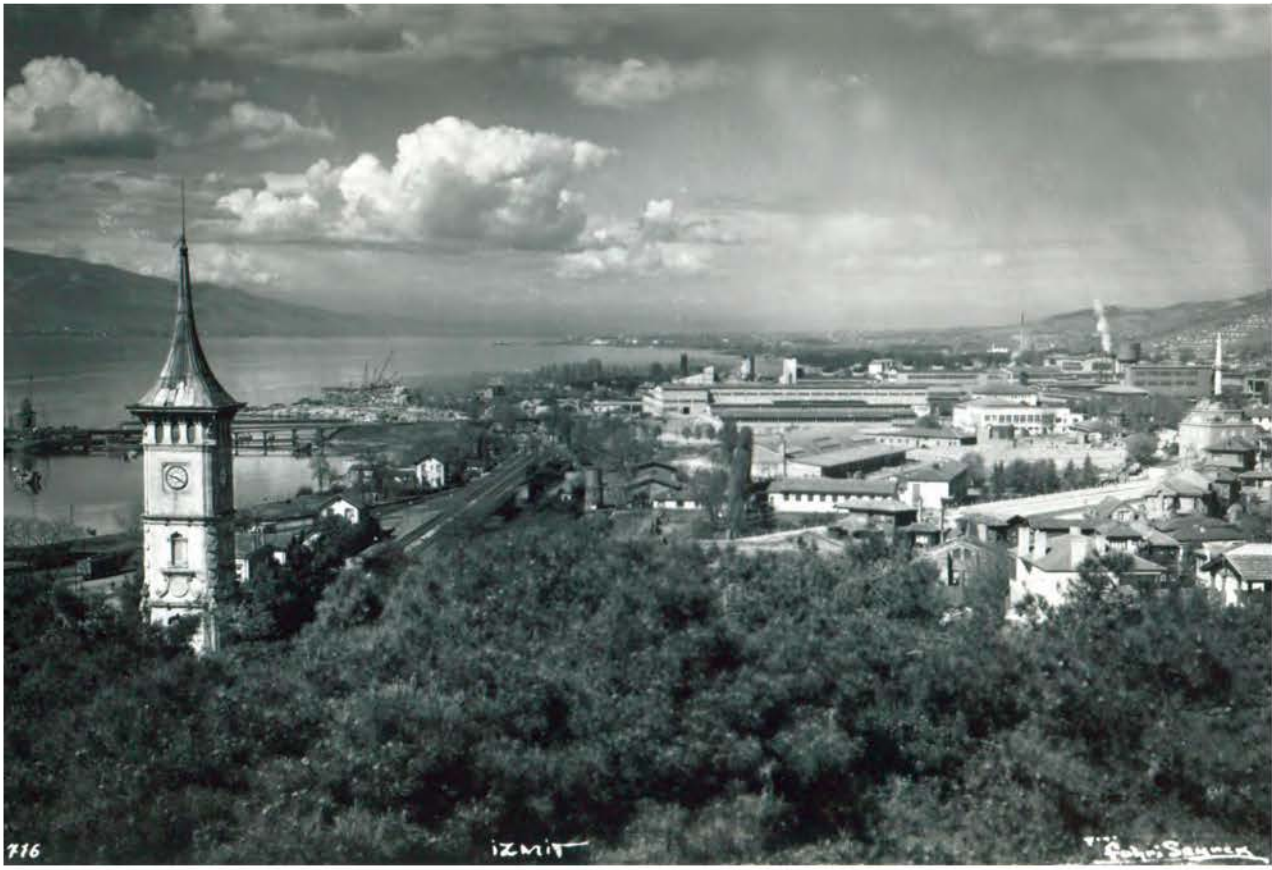
1956, İzmit Saat Kulesi, İstasyon ve SEKA Kağıt Fabrikası.
