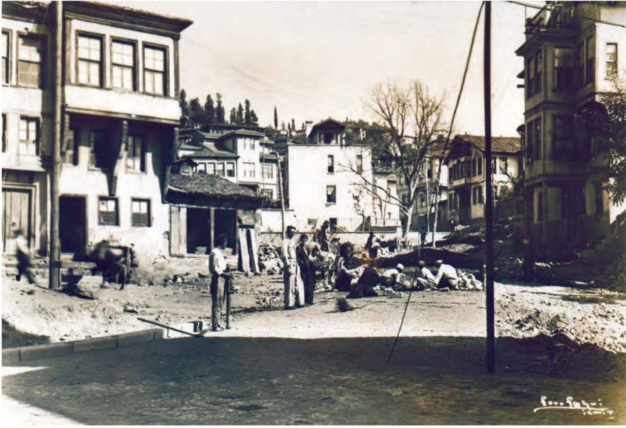
1944, Çarşıbaşı (Acısu) Meydanı'na kaldırım döşenmesi çalışmaları.
