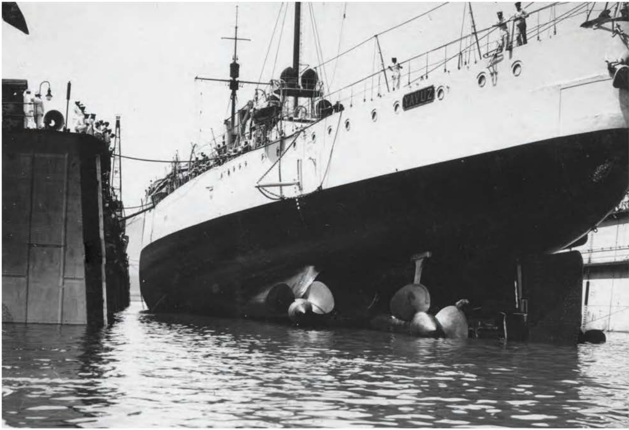
26 Temmuz 1933, Havuz su alarak batırılıp, Yavuz havuzdan çıkartılırken. İskele kış omuzluktan görünüşü.
