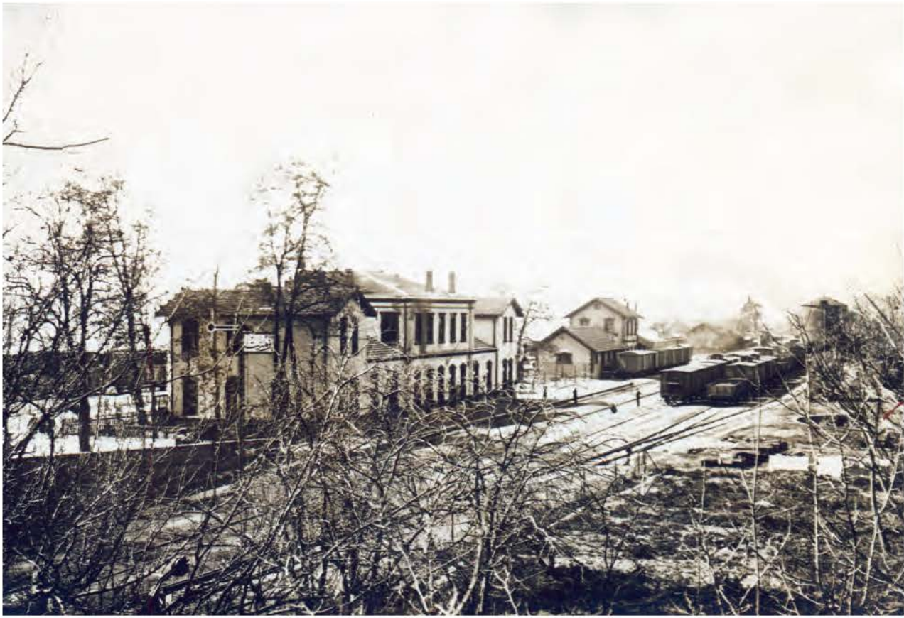
1920'ler, Bir kış sabahında Adapazarı yönünden İzmit İstasyonu girişi.
