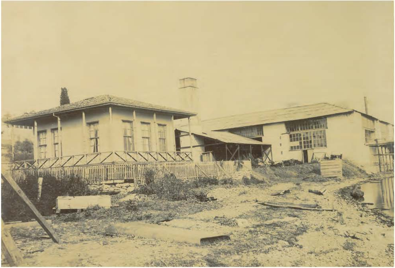
19.yy. sonları, Sultan Abdlmeçid adına İzmit'te inşa olunan İzmit Tersanesi'nin demir fabrikası.
