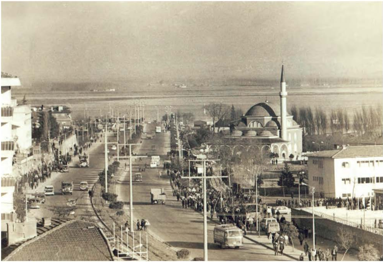
1970, E-5 (D-100) Karayolu şehir içi geçişi. Sağda "Kapalı Spor Salonu" ve "İzmit Yetiştirme Yurdu", arkada ise "Seka Camii" görülüyor.
